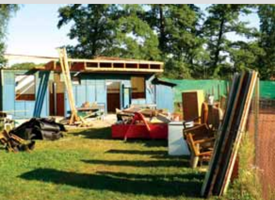
Rekonstrukce tenisových kurtů
