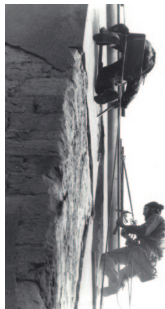
Na cesty bylo třeba si vydělat – výškové práce
