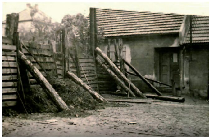
Vnitřní barikáda zamezující průjezd nádvořím Barborky (foto z neděle 6. května 1945)
