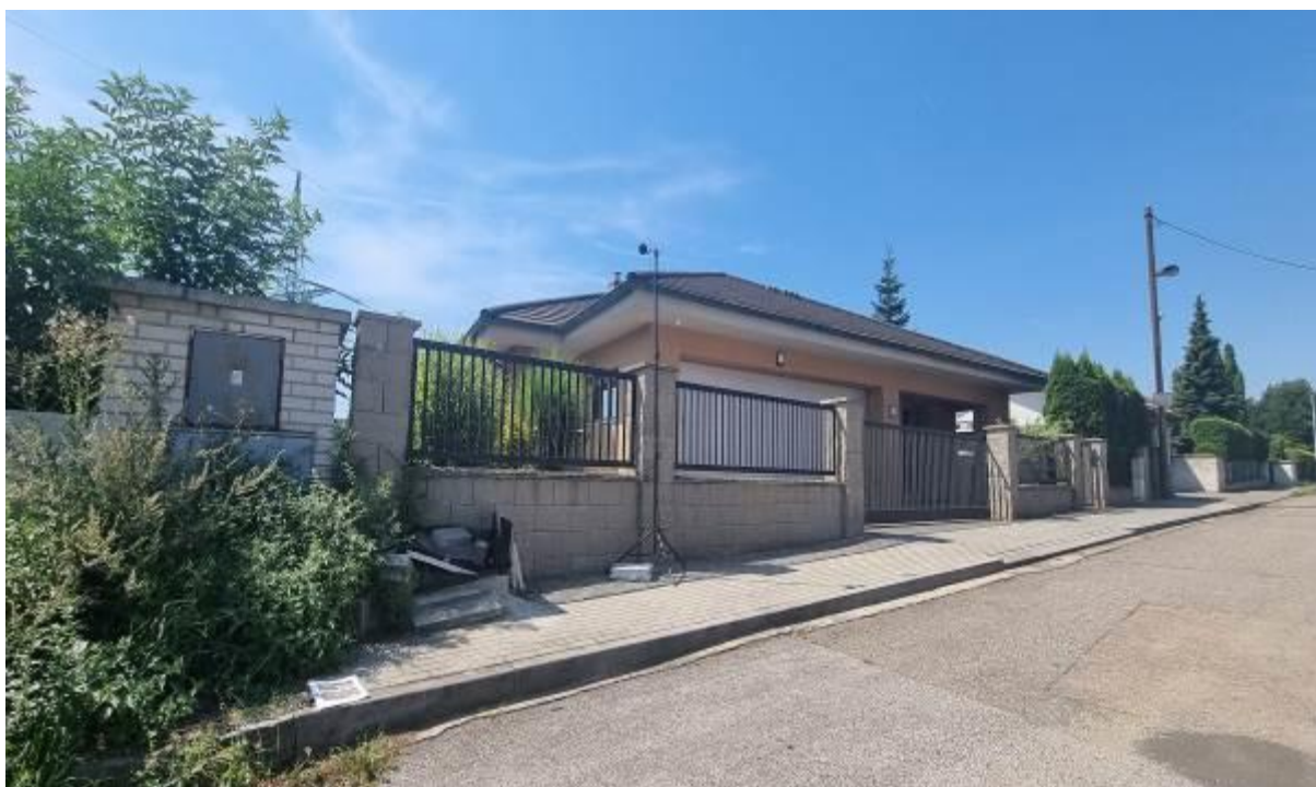
OBR. 10 Měřicí místo č. 10 RD č.p. 2613/10, ul. Na Svěcence, 193 00 Praha 9
