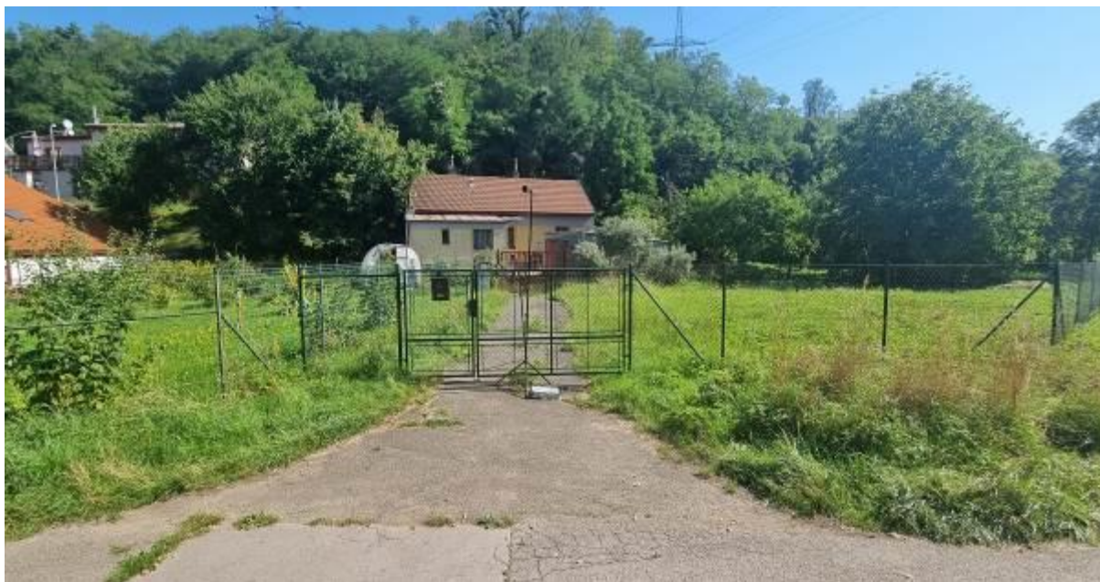
OBR. 4 Měřicí místo č. 4 RD č.p. 23, ul. Za Rokytkou, 198 00 Praha 9
