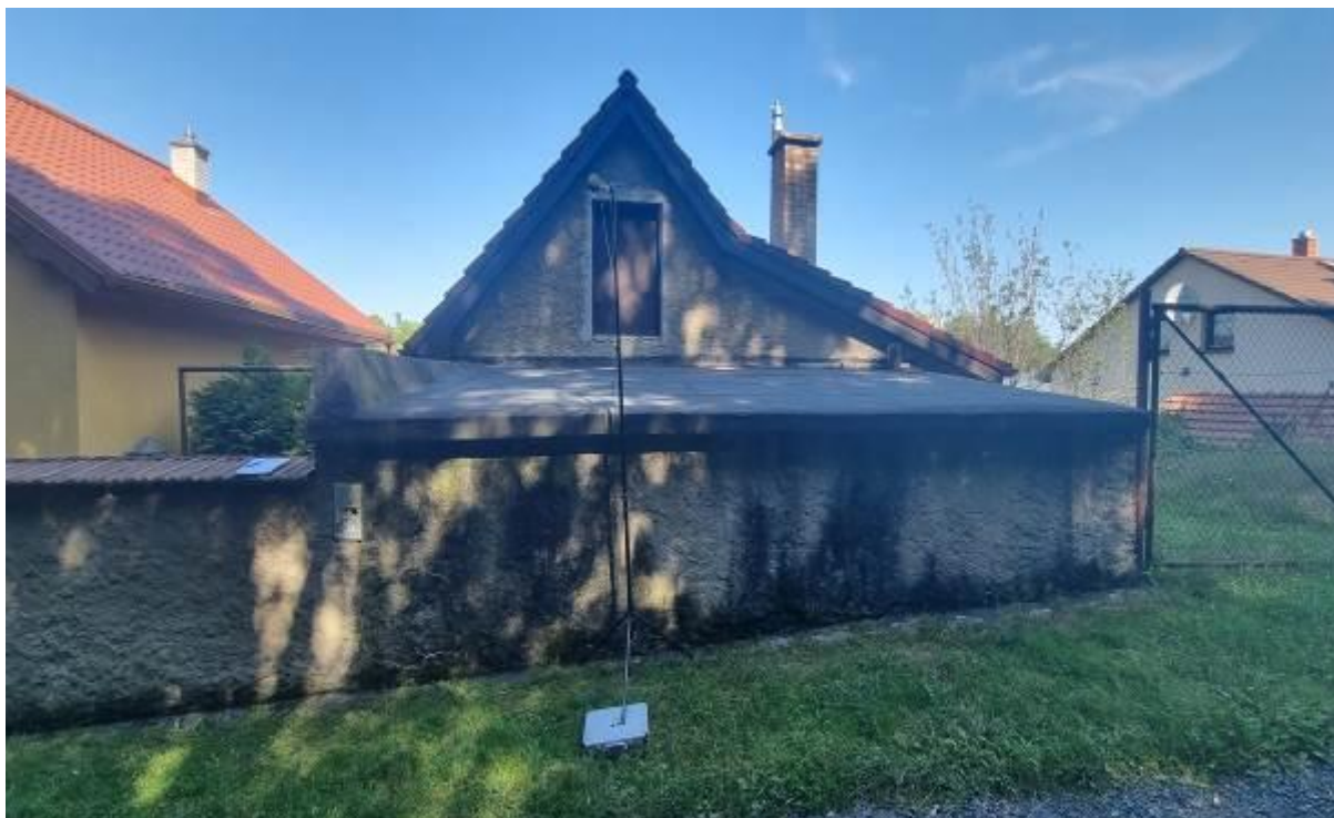
OBR. 6 Měřicí místo č. 6 RD č.p. 123, ul. Za Rokytkou, 198 00 Praha 9
