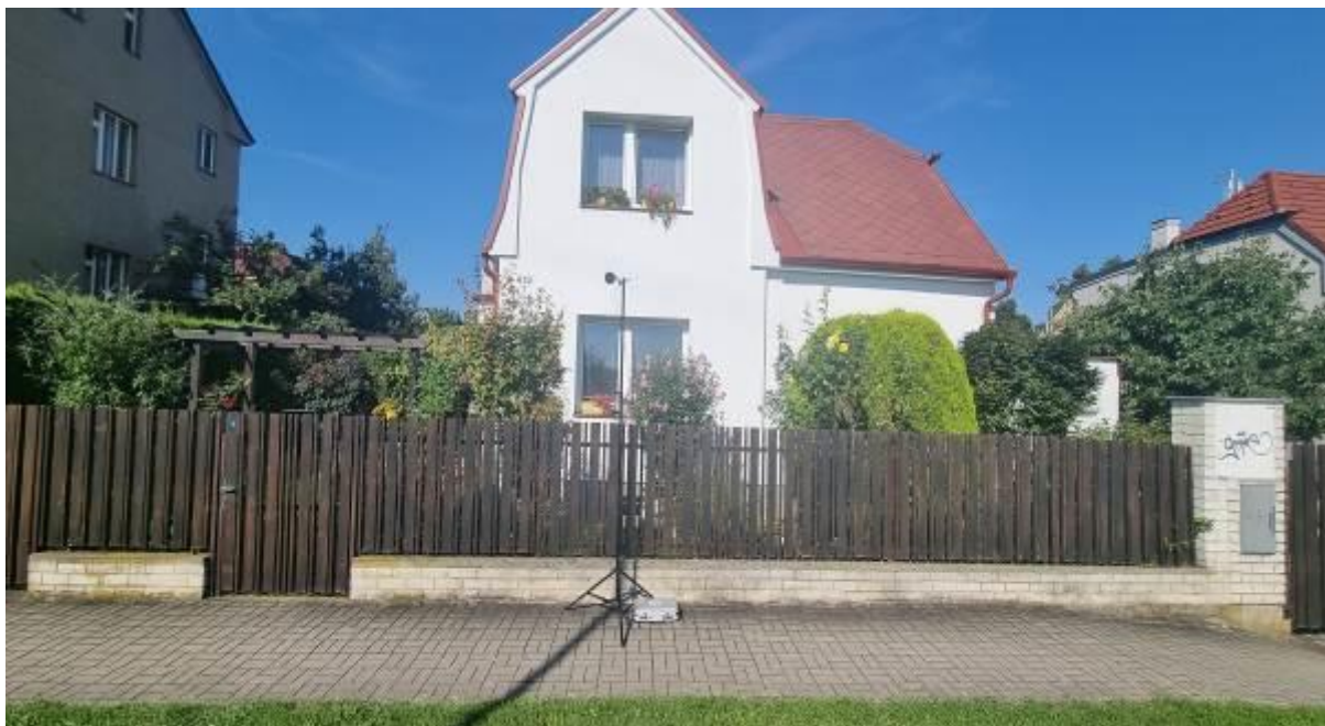
OBR. 3 Měřicí místo č. 3 RD č.p. 430, ul. Broumarská, 198 00 Praha 9
