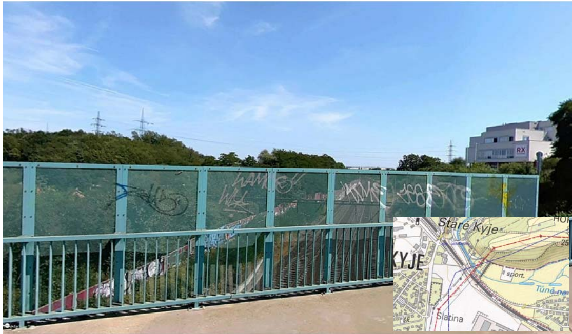
Vizualizace 3 Současný stav vedení při pohledu na stožárové místo č. 9 a 10 z mostu nad železnicí ve Starých Kyjích
