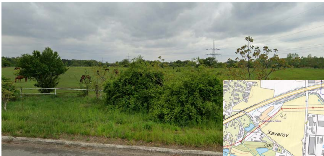
Vizualizace 20 Současný stav vedení při pohledu na stožárová místa č. 23-25 u Xaverova, podél Svěpravického potoka
