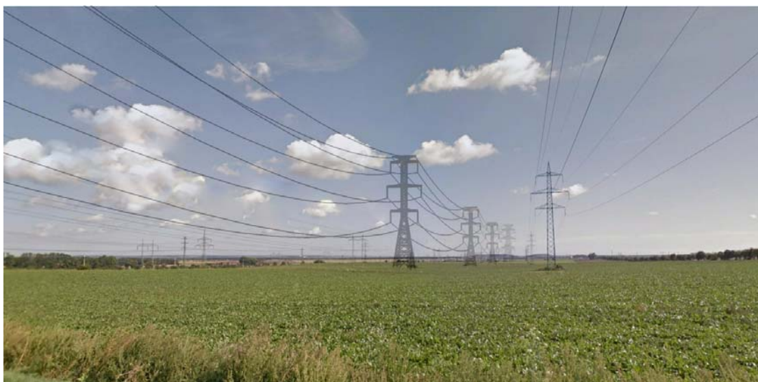
Vizualizace 31 Vizualizace navrženého řešení V205/206 při pohledu na stožárová místa č. 55-50 ve variantě Soudek
