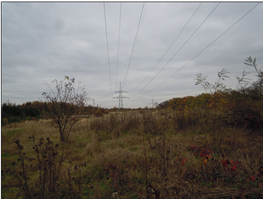
Obr. 5 Pohled od stávajícího st. č. 9 směrem ke st. č. 10
