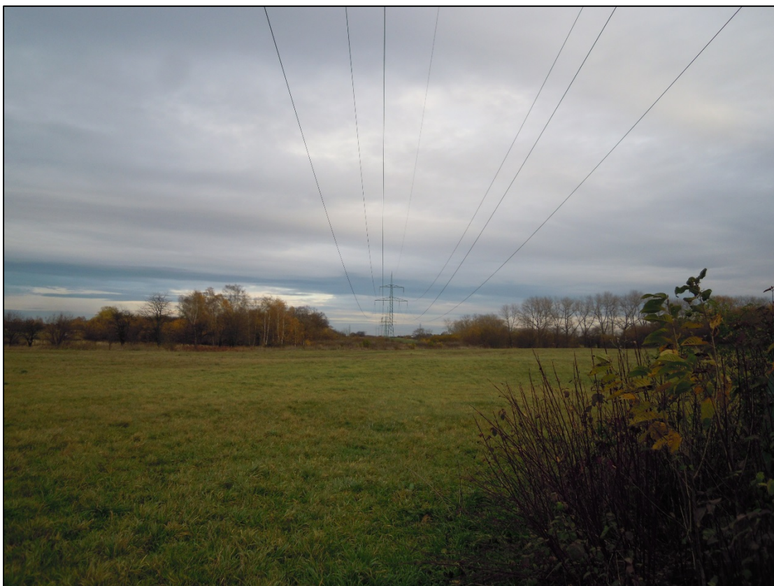
Obr. 11 Pohled od stávajícího st. č. 26 směrem ke st. č. 27
