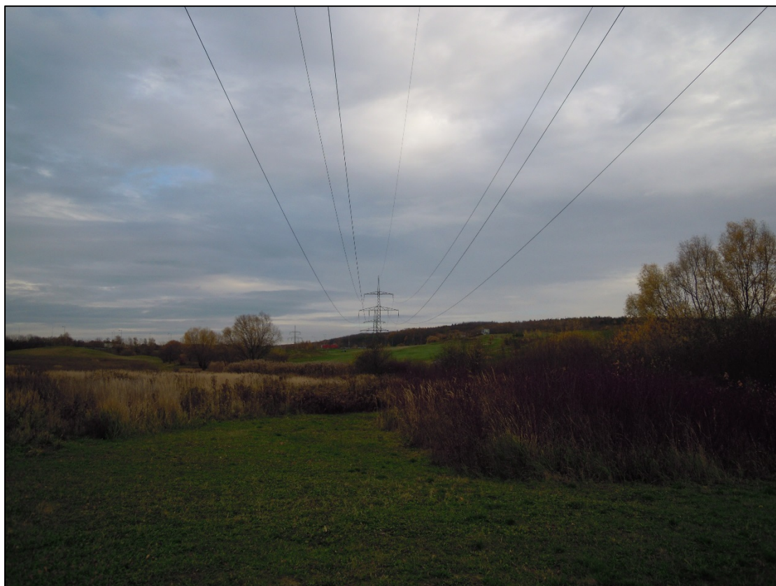
Obr. 9 Pohled od stávajícího st. č. 16 směrem ke st. č. 17
