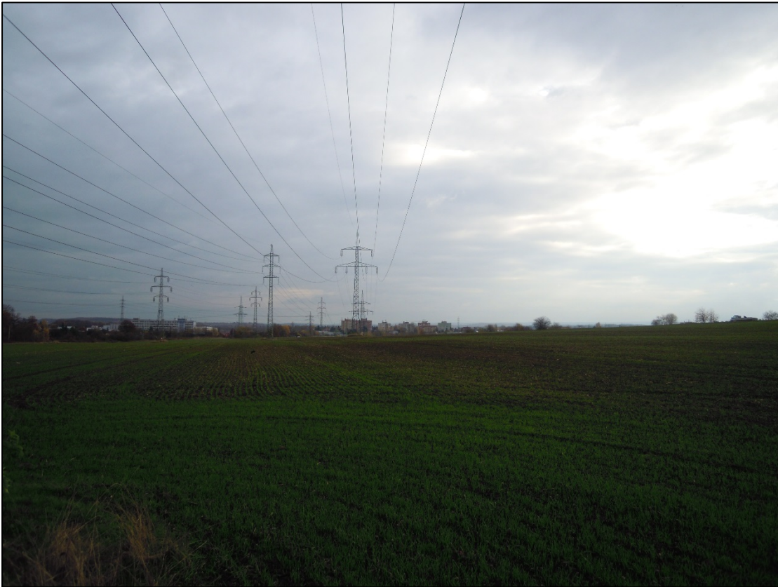
Obr. 3 Pohled od stávajícího st. č. 4 směrem ke st. č. 5
