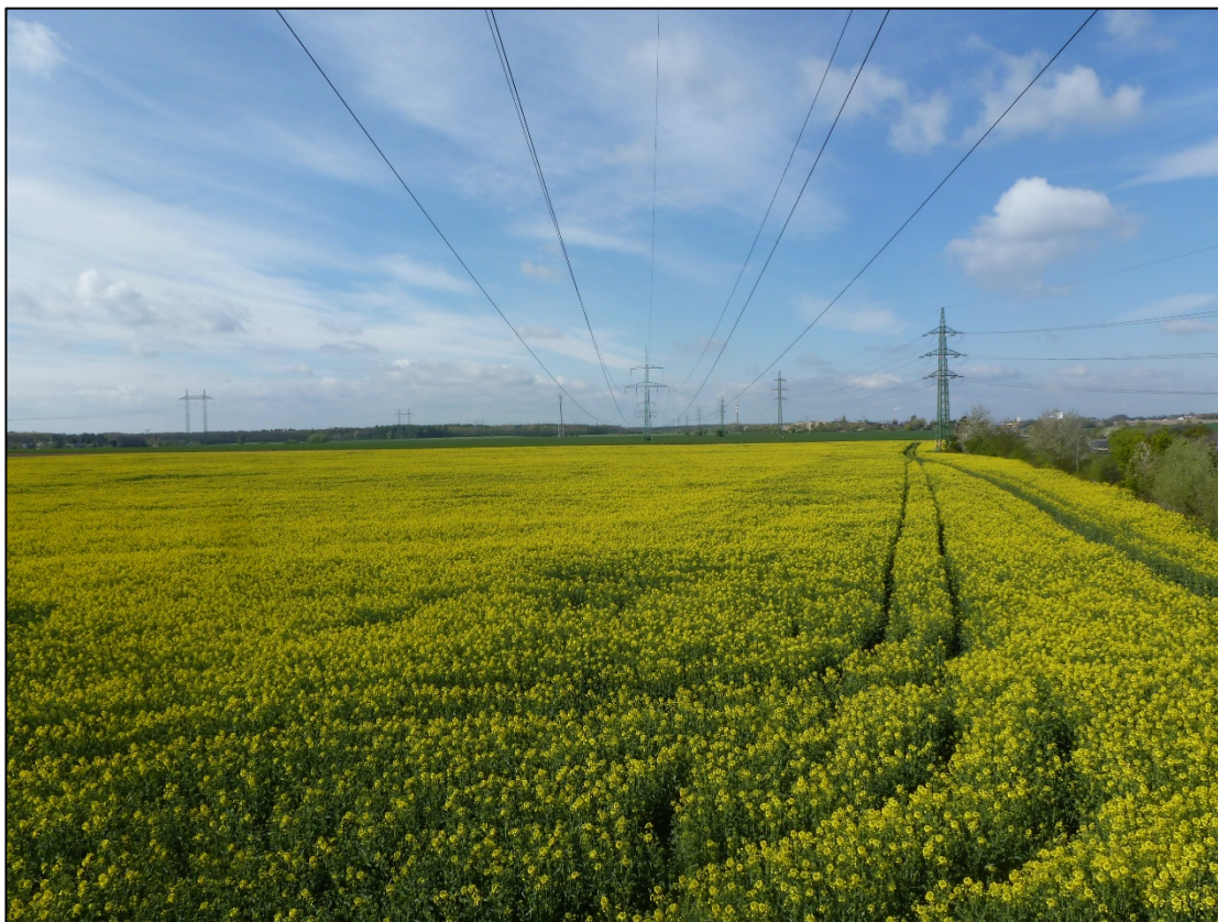
Obr. 12 Pohled od stávajícího st. č. 33 směrem ke st. č. 32
