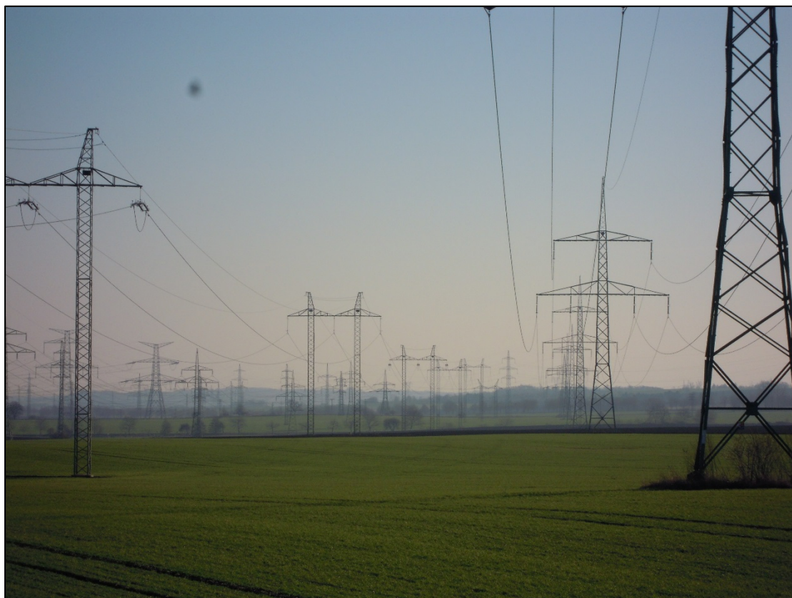
Obr. 15 Pohled od stávajícího st. č. 50 směrem ke st. č. 51
