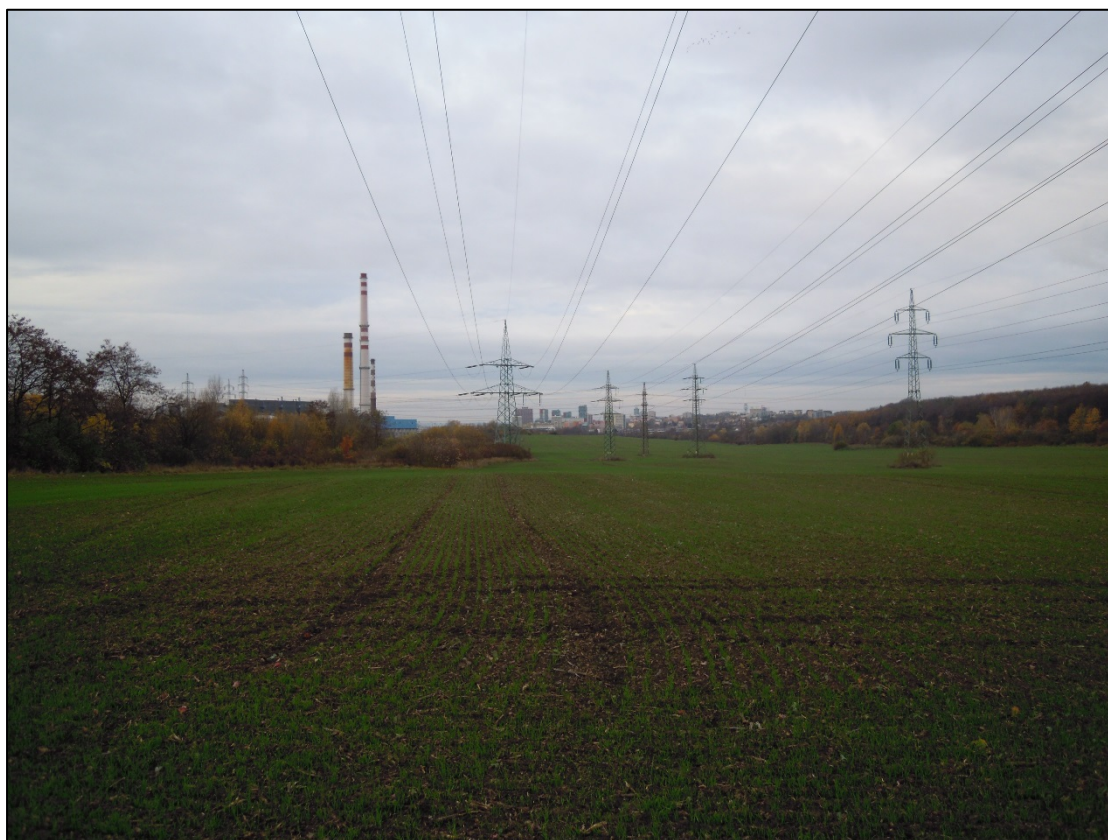
Obr. 2 Pohled od stávajícího st. č. 3 směrem ke st. č. 2
