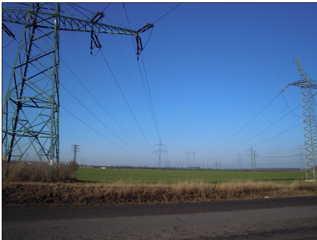
Obr. 16 Pohled od stávajícího st. č. 55 směrem ke st. č. 54
