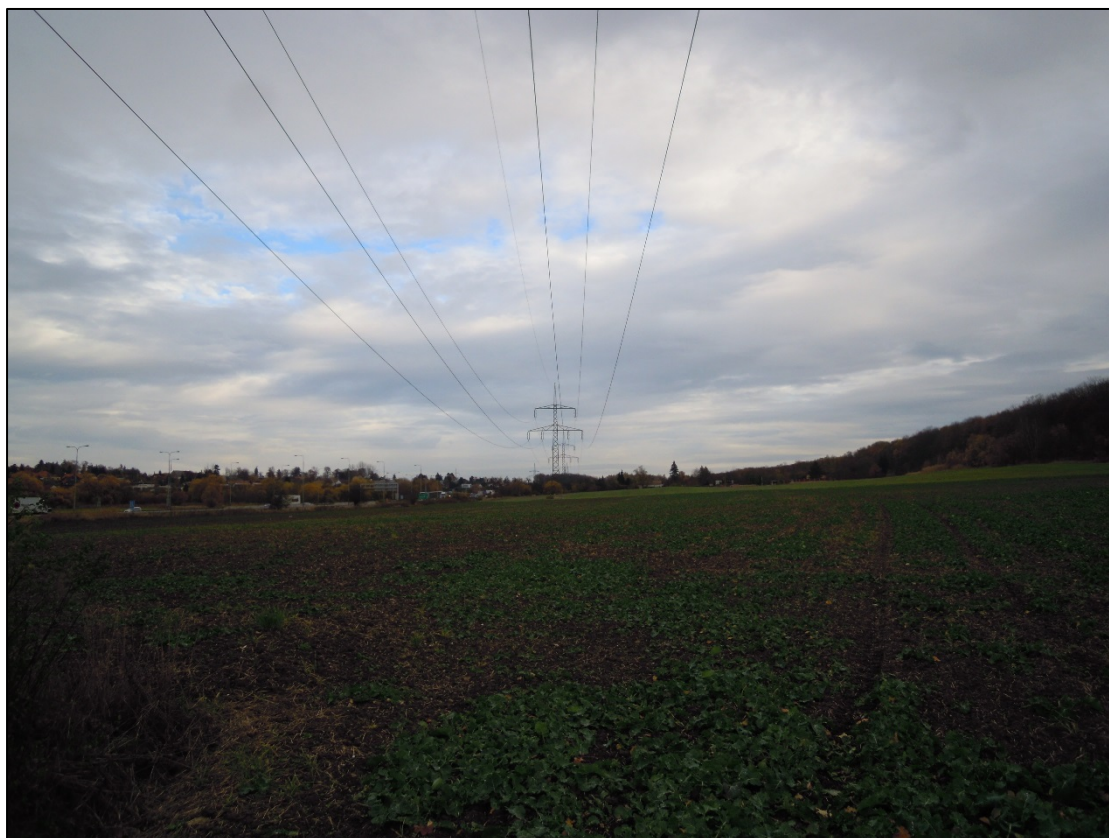
Obr. 10 Pohled od stávajícího st. č. 19 směrem ke st. č. 20
