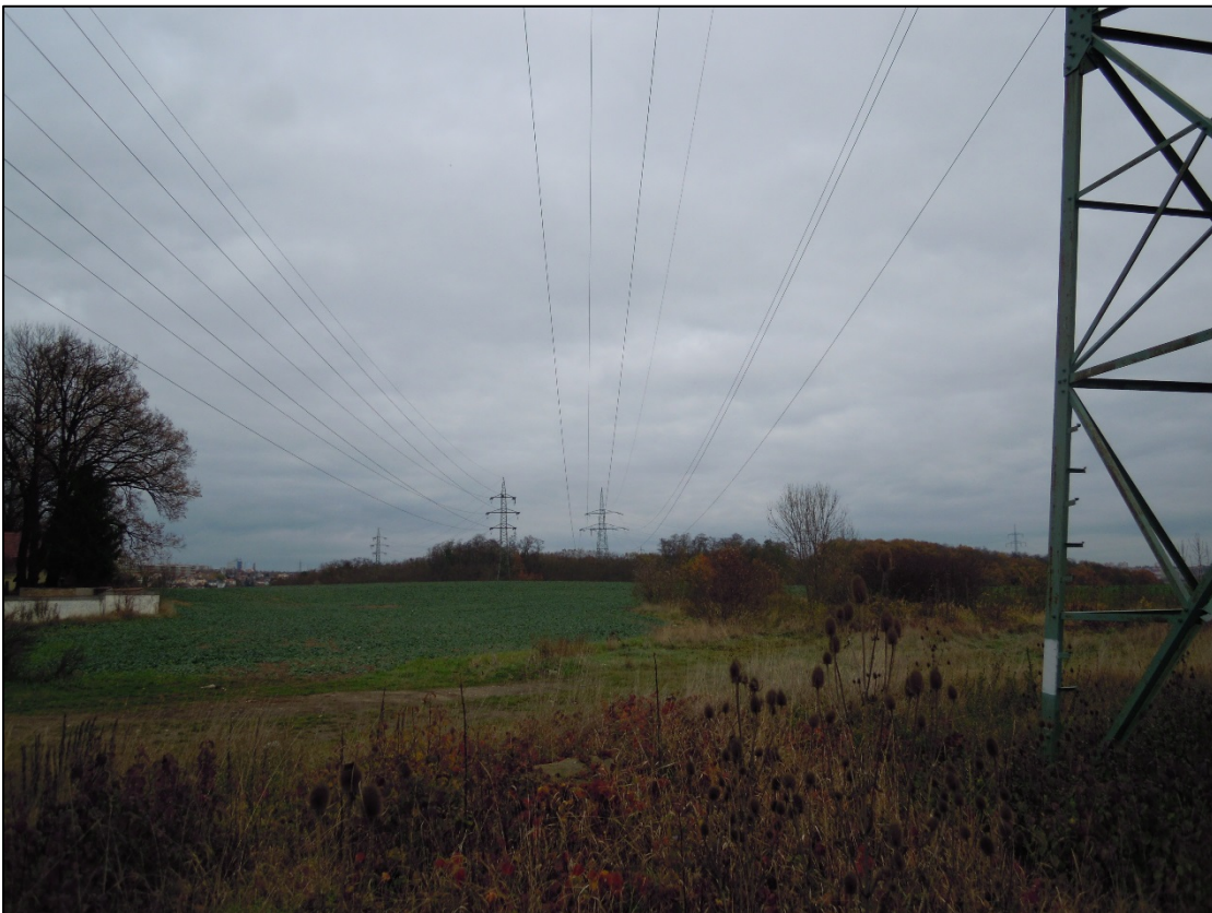
Obr. 4 Pohled od stávajícího st. č. 8 směrem ke st. č. 9, v pozadí přírodní park Klánovice - Čihadla
