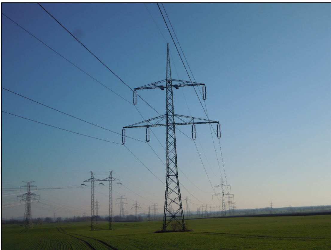
Obr. 14 Pohled od stávajícího st. č. 49 směrem ke st. č. 50
