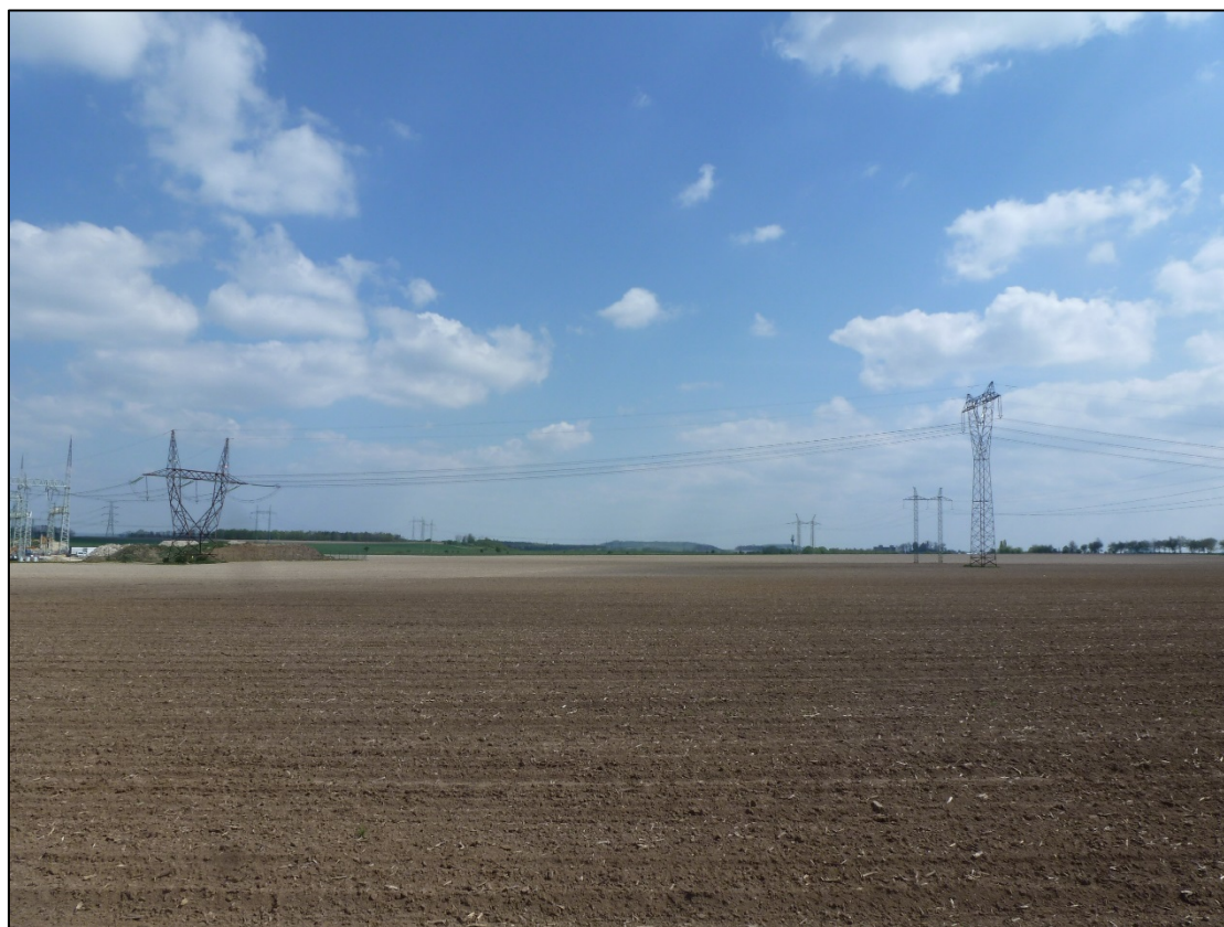
Obr. 18 Místo napojení nového vedení 400 kV na vedení V415/495
