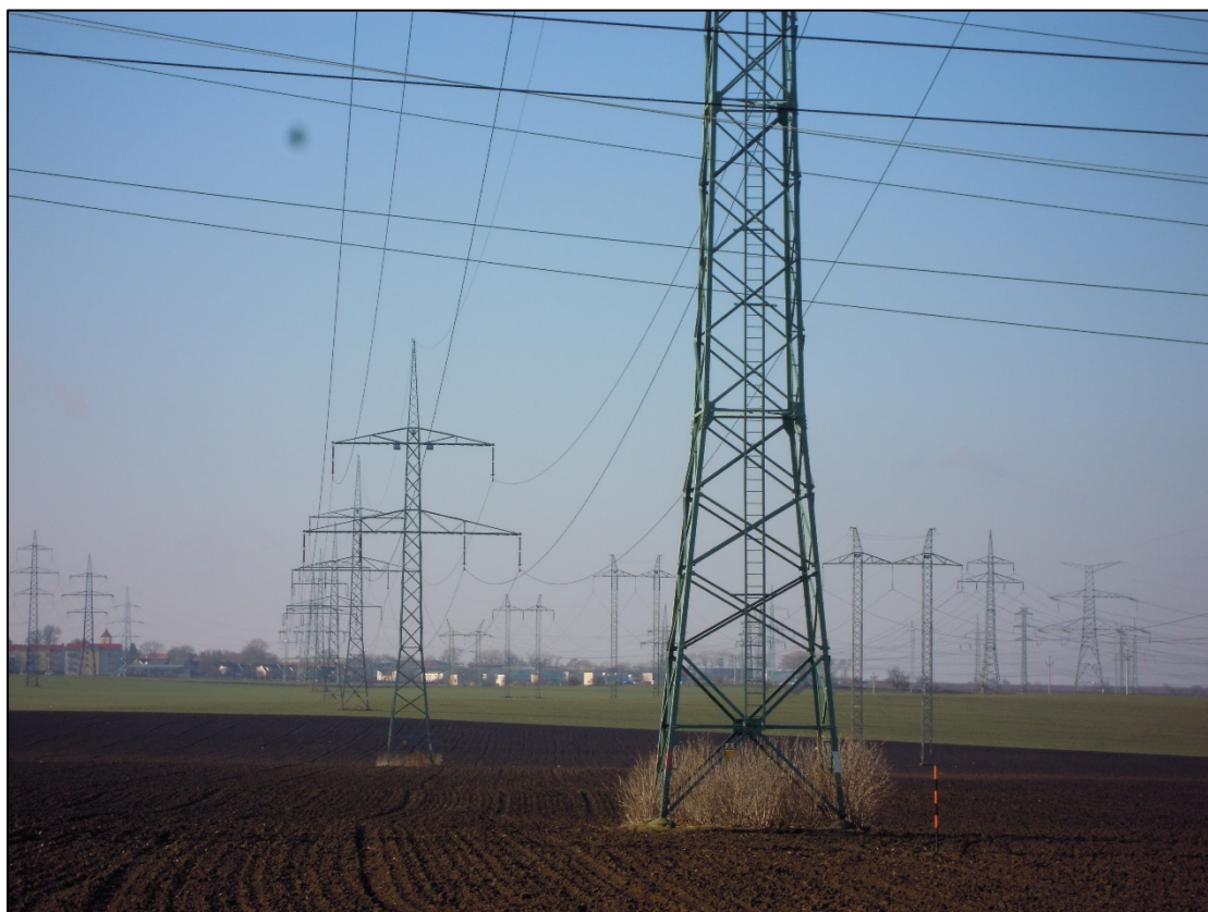
Obr. 17 Pohled od stávajícího st. č. 59 směrem ke st. č. 58
