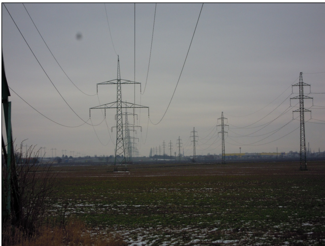
Obr. 13 Pohled od stávajícího st. č. 42 směrem ke st. č. 41
