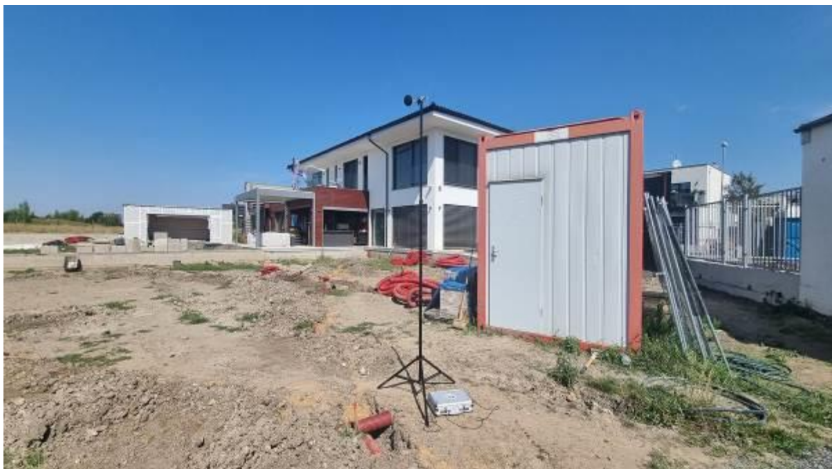
OBR. 7 Měřicí místo č. 7 RD č.p. 556/24, ul. Bergmanova, 198 00 Praha 9
