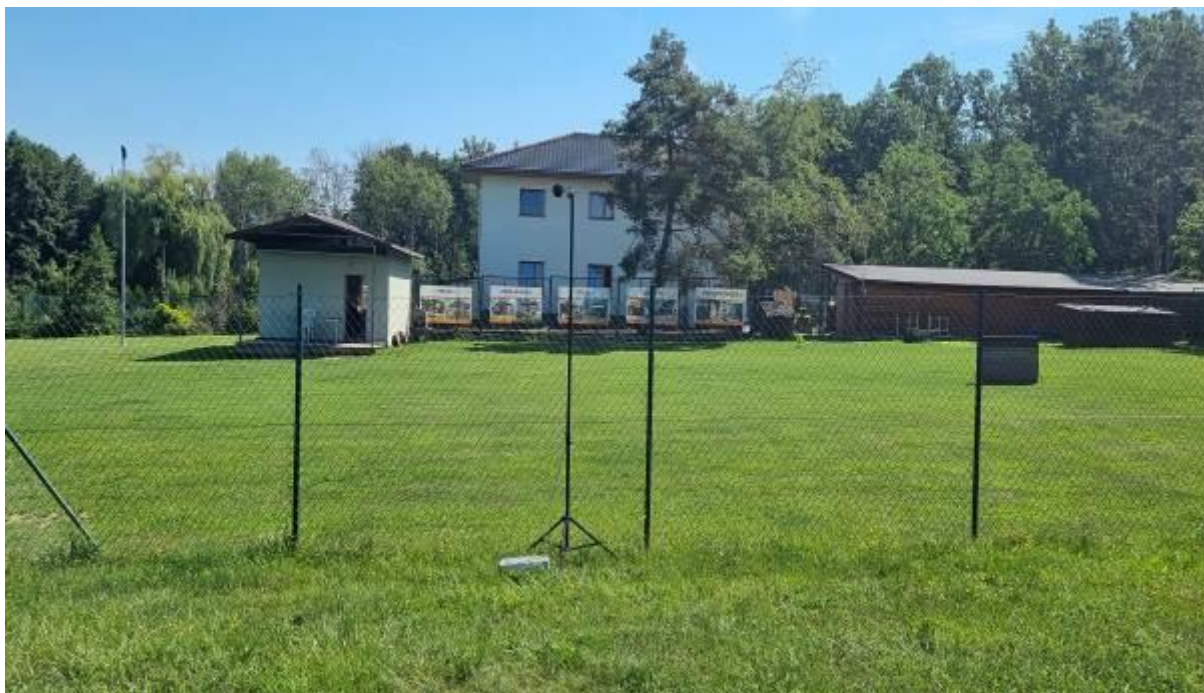
OBR. 9 Měřicí místo č. 9 RD č.p. 1589, ul. U hvozdů, 193 00 Praha 9
