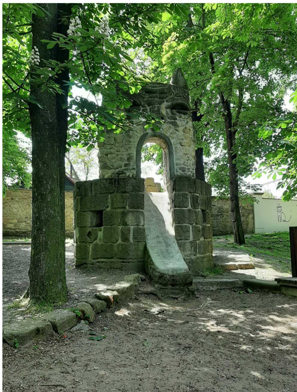
Kočí hrádek po rekonstrukci
