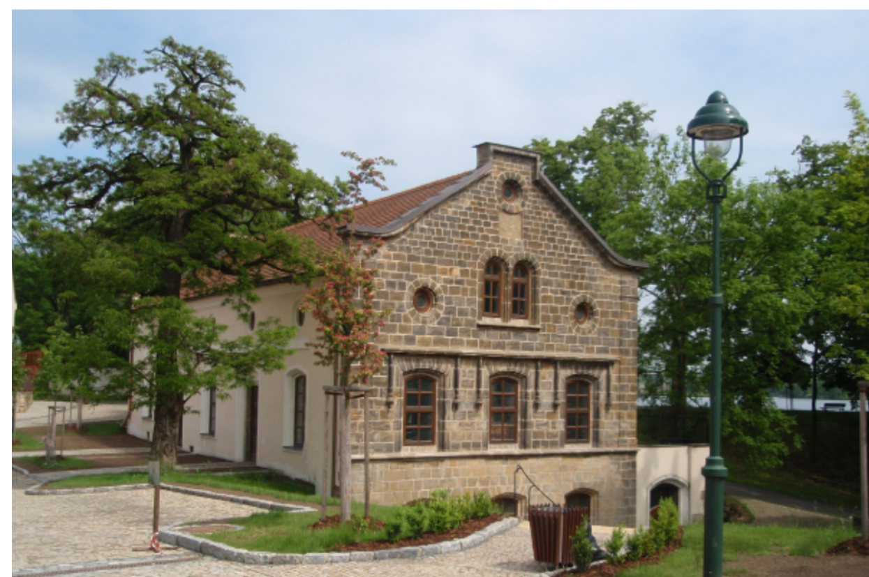
Bývalý mlýn - čelní kamenná fasáda
