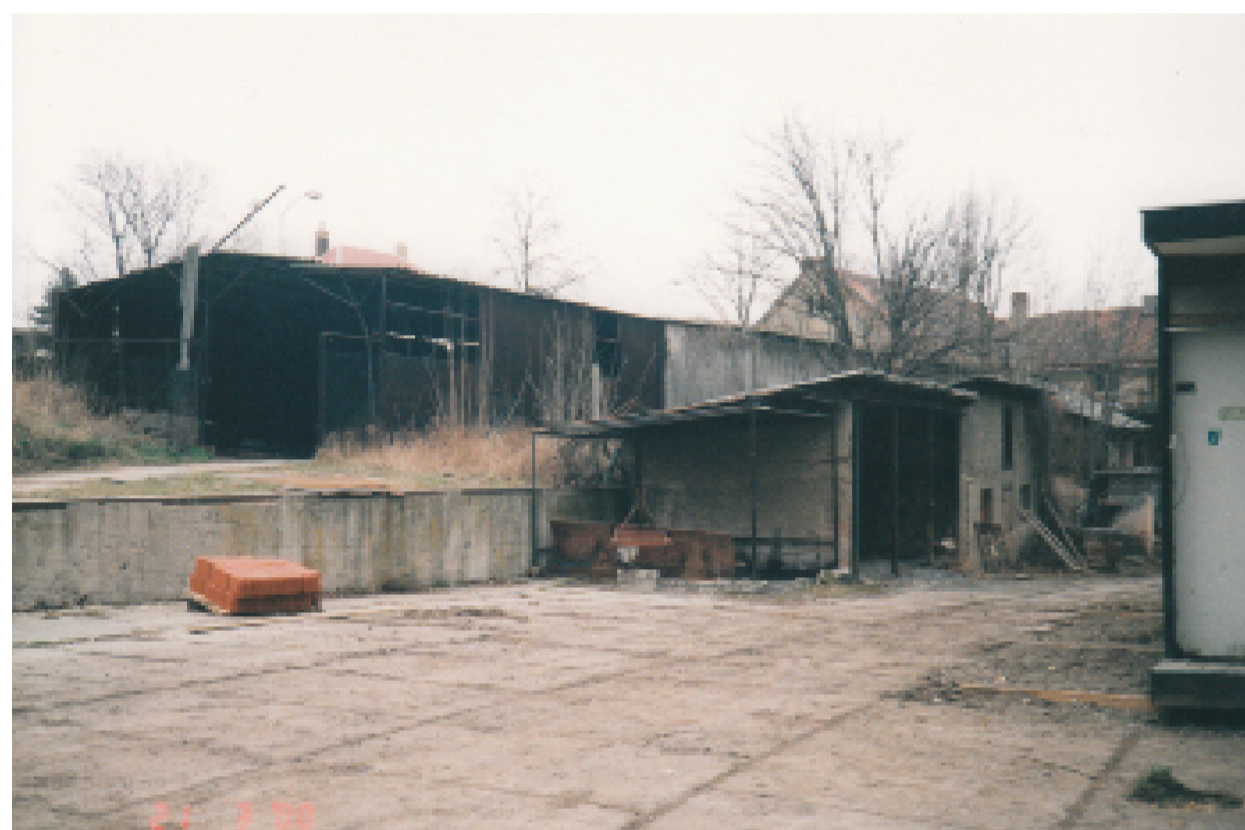
Areál před rekonstrukcí
