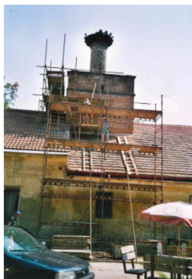
Rekonstrukce počernického pivovaru
