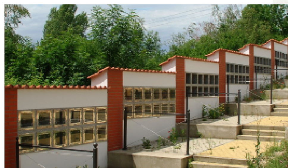
Nově vybudovaná hřbitovní zeď
