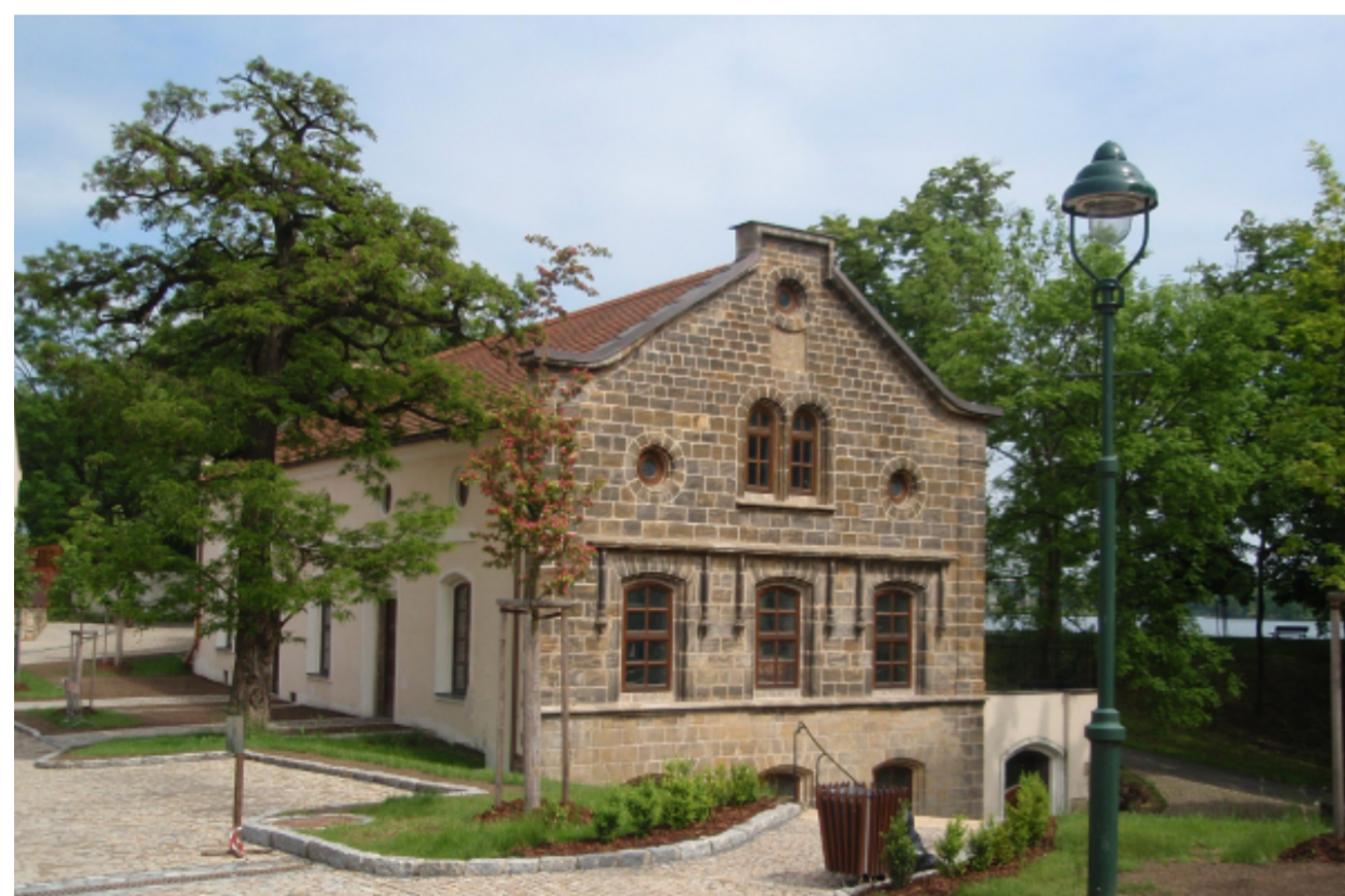
Bývalý mlýn - čelní kamenná fasáda
