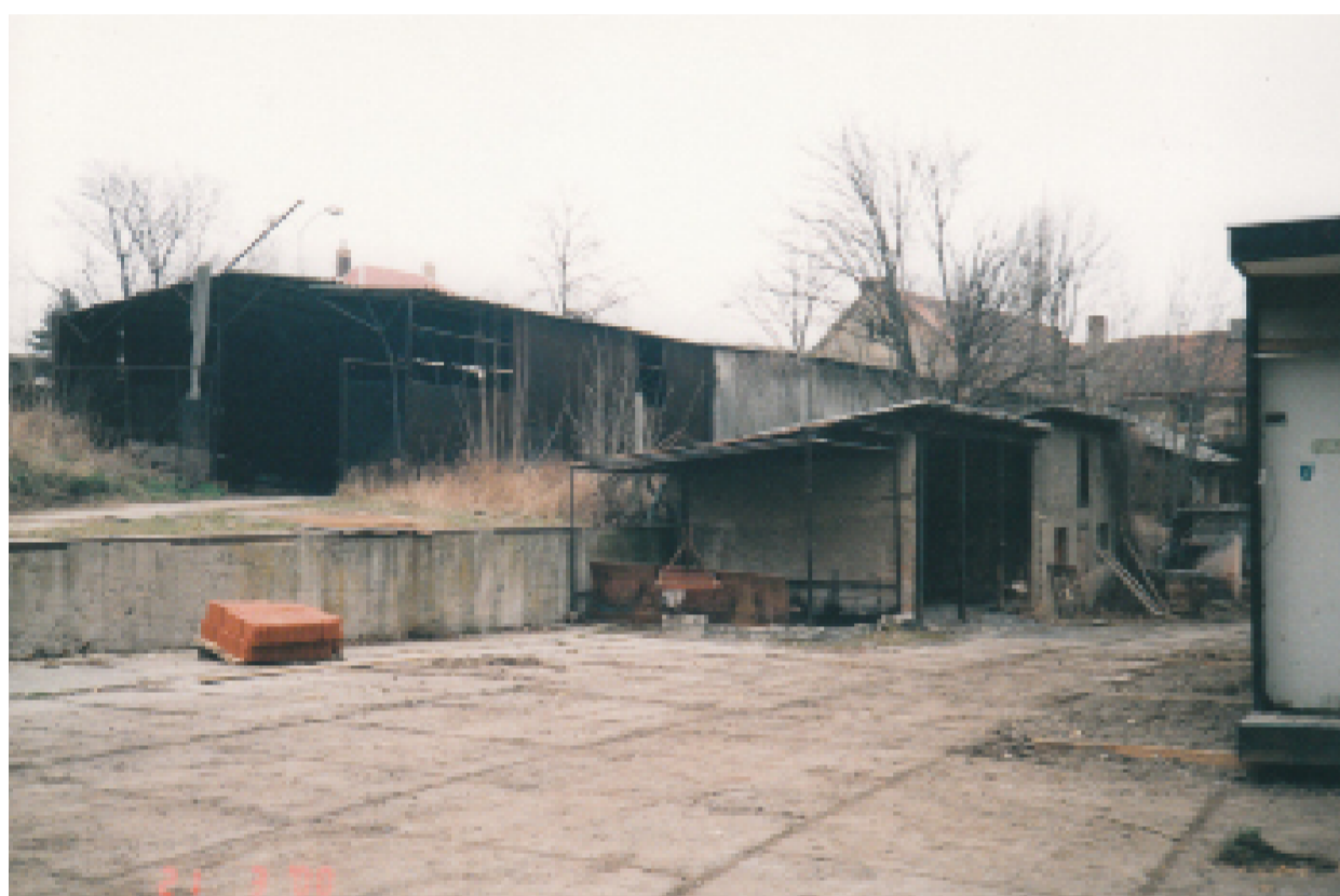
Areál před rekonstrukcí
