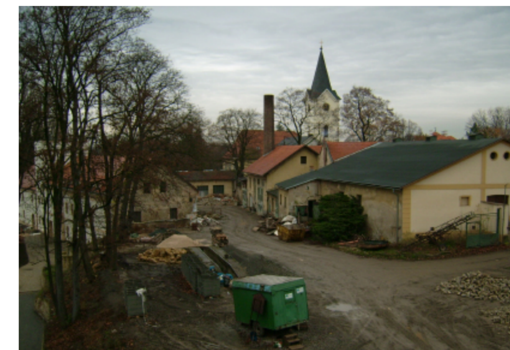
Nádvoří pivovaru před rekonstrukcí
