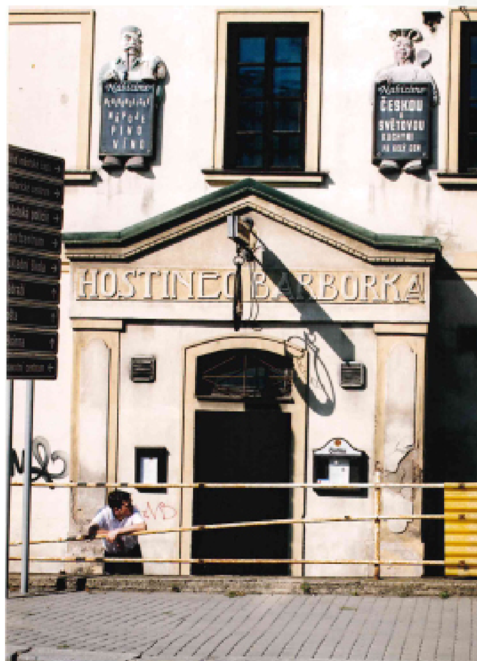
Vstupní průčelí hostince
