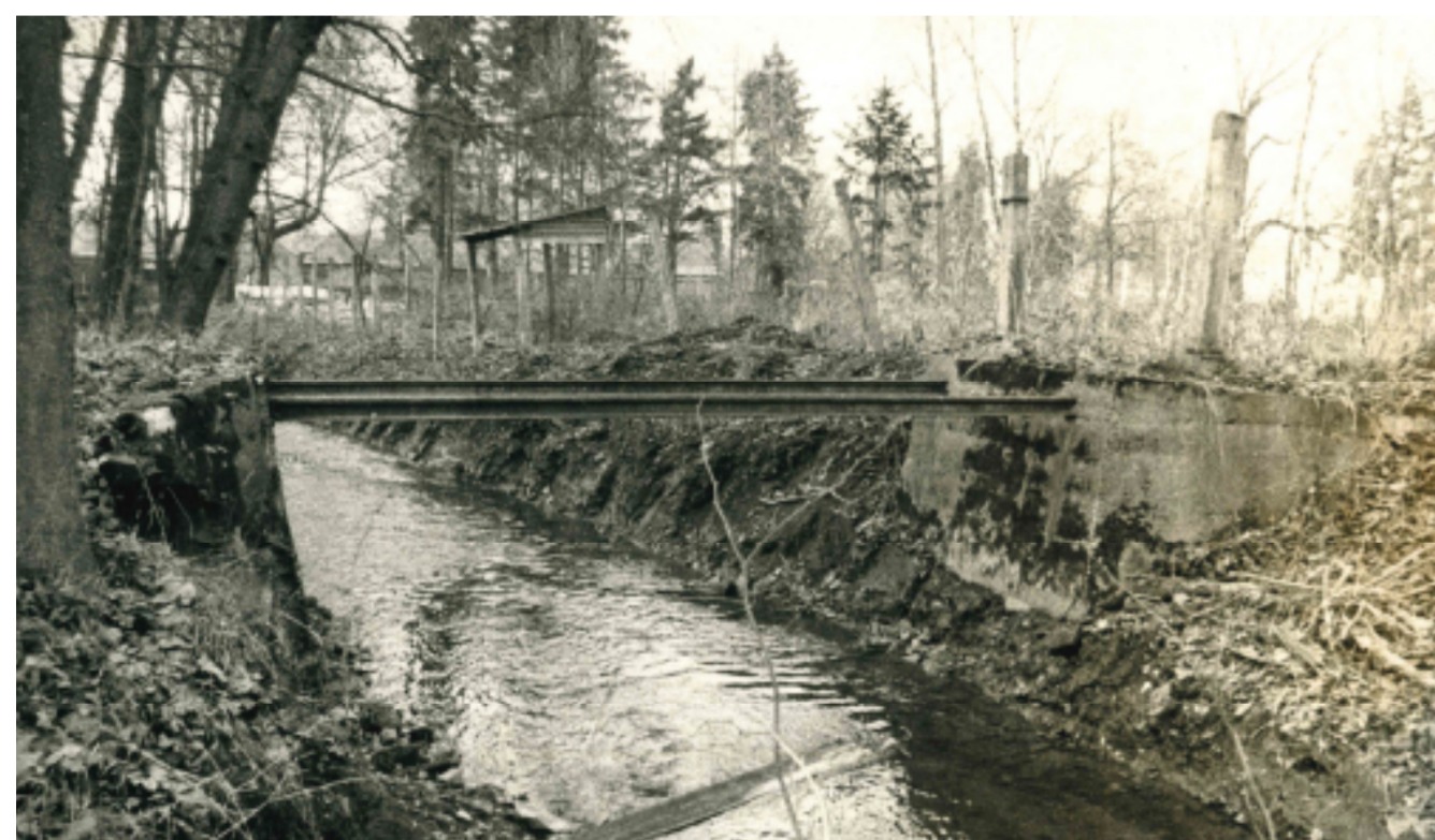
Původní mostky před rekonstrukcí
