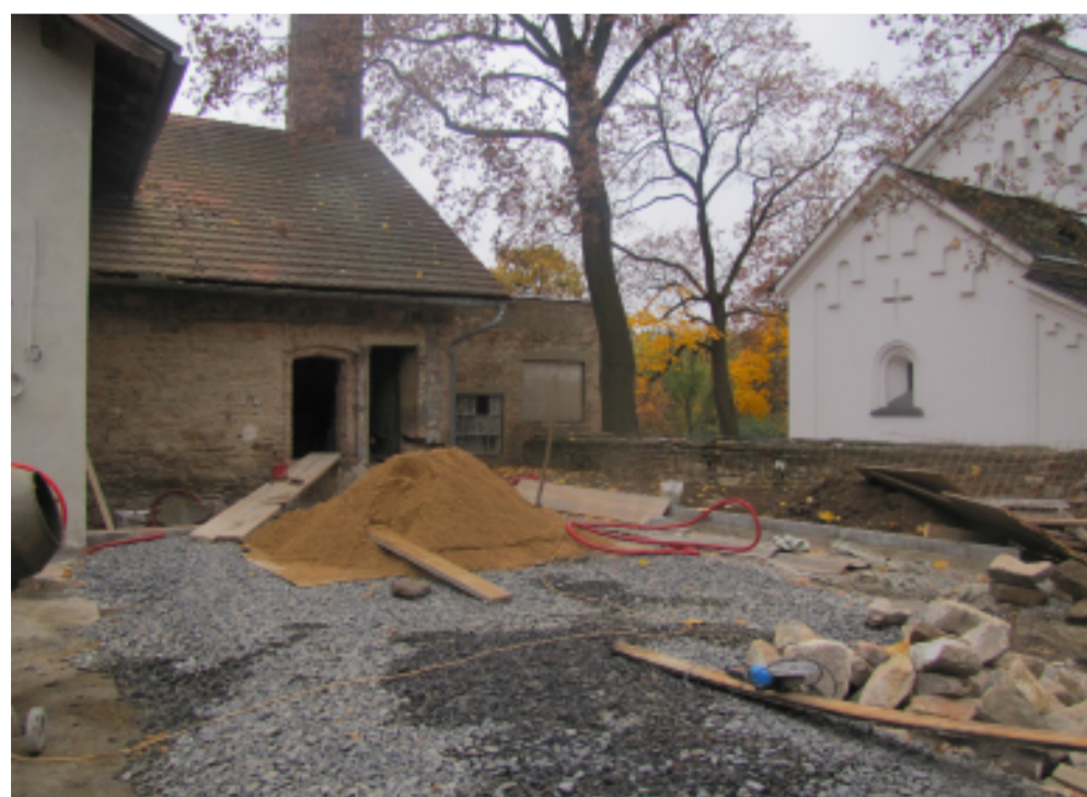
Nádvoří pivovaru během rekonstrukce
