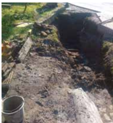
Zanesená a rozpadlá část kanalizace
